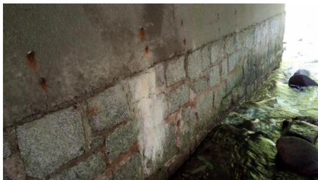
-Zatékání na pilíř
