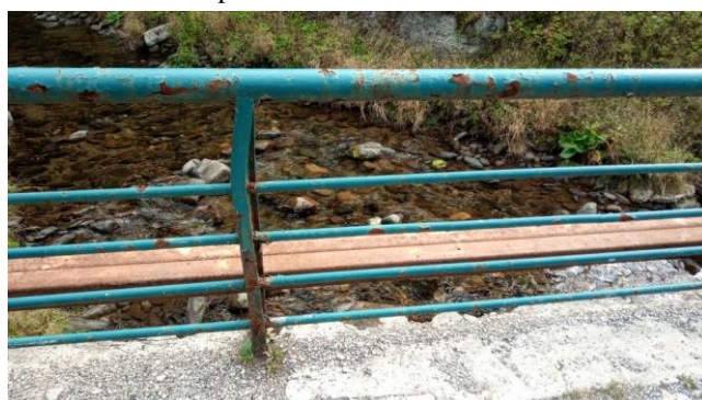
-Deformované zábradlí vpravo
