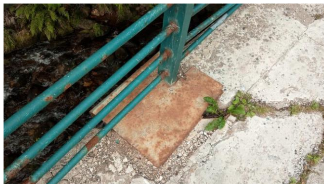
-Krycí plech dilatační spáry
