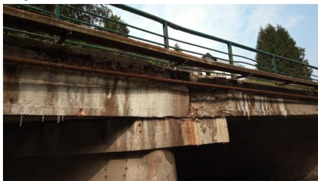
-Zatékání na P2, rozpad konců nosníků a koncových příčníků
