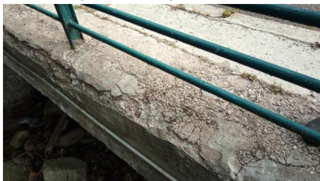
-Degradace říms
