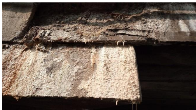
-Zatékání na konce nosníků
